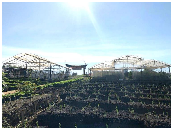
ハウスの骨組み、竹から鉄骨完成
