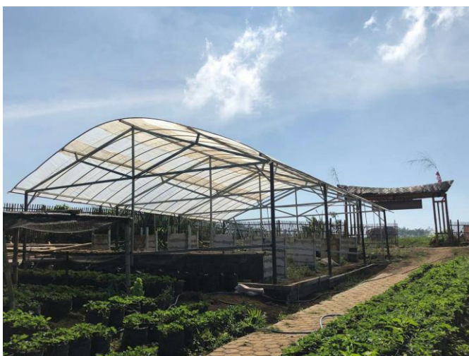
ハウスの骨組み、竹から鉄骨完成
